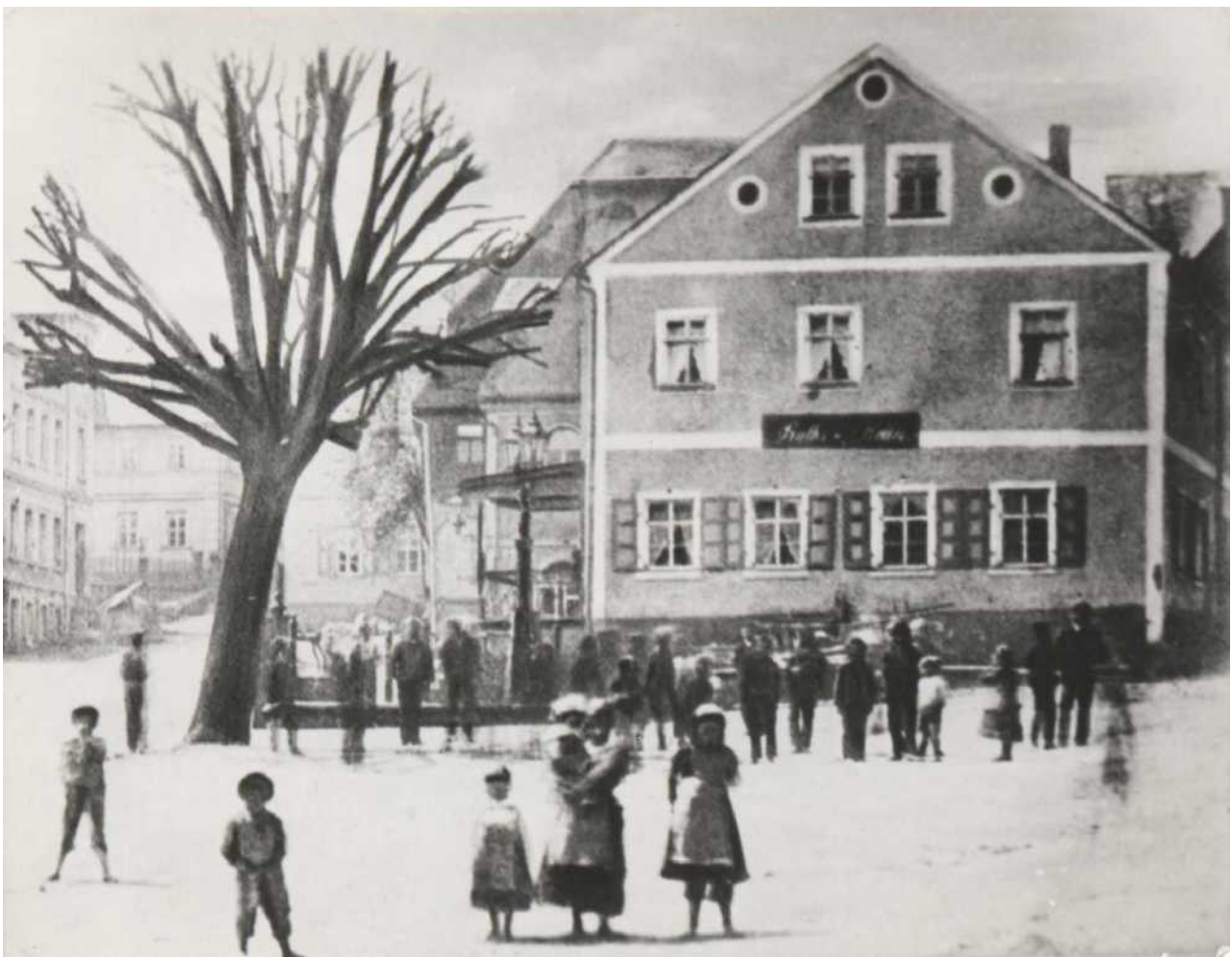
Der abgebrannte alte "Ratskeller" stand an der unteren Ecke des Parkplatzes, an der Verlängerung von Bahnhof- und Schlossstraße.
