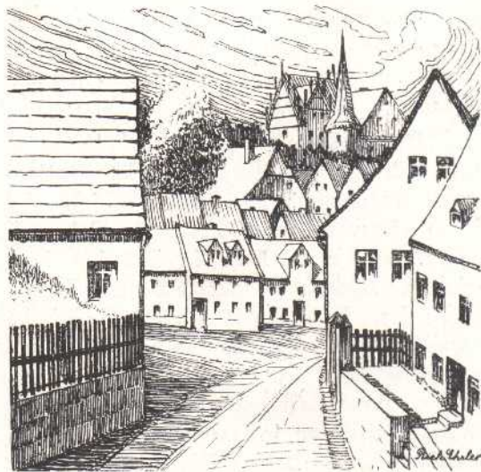
Der Markt von Netzschkau vor dem Brand (Blick von der Plauenschen Straße aus)
